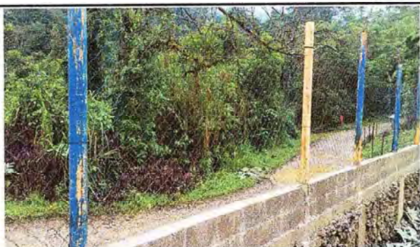
Foto 3: Cerco perimetral con block y malla completamente terminado.
