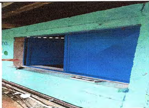
Foto 1: Ventana de metal instalada a la cocina.
