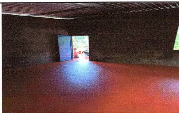
Foto 3: Piso completamente nuevo en el salón de clases.
