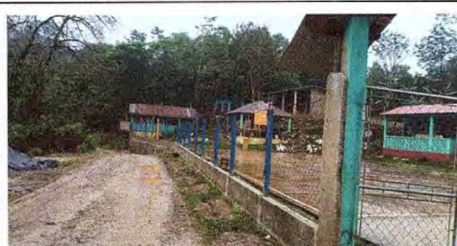
Foto 4: El perímetro de la escuela se encuentra completamente cerrada con block y malla galvanizada.
