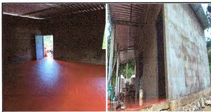
Foto 6: Interior y exterior del salón de clases que se le dio mantenimiento.
