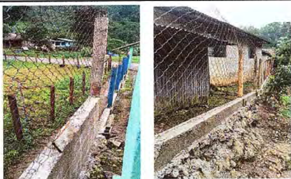
Foto 5: El cerco perimetral, ahora protege completamente las instalaciones de la escuela.
