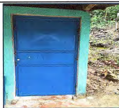
Foto 6: Puertas de metal completamente nuevas en la cocina.
