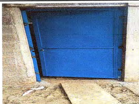
Foto 2: Puerta de metal instalada en el salón de clases.
