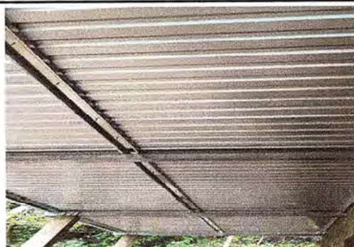
Foto 2: Corredor del salón de clases, con estructura nueva de metal.
